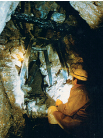
Untertägiger Streckenausbau aus dem 18. oder 19. Jahrhundert: ein hölzerner Türstock stützt die Grubenbaue des Kupferbergwerks.
