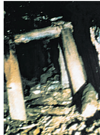
Mittelalterlicher Stollenausbau durch Holz an verbruchgefährdeten Bereichen in der Grube „St. Sebastian“, die im 16. Jahrhundert hohe Golderträge lieferte.
