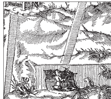
Viele Jahrhunderte ändert sich die Arbeit des Bergmanns nicht: Streckenvortrieb in mühevoller Handarbeit mit Hammer und Meißel (Schlägel und Eisen) in dunklen, engen und feuchten Strecken.
